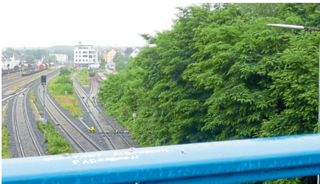
Zwischen Gleisanlagen und Nordstraße (im Hintergrund der Nordcube) soll der „Greiteler Bogen“ mit gut 100 Wohnungen sowie Büros entstehen. Das fünfte Gebäude reicht bis in die Nähe der Brücke. FOTO: SABINE KAUCHE
