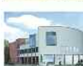
Servicewohnanlage Nottuln (2012) 17 Wohneinheiten | 1 Sozialstation 1 Gewerbeeinheit
